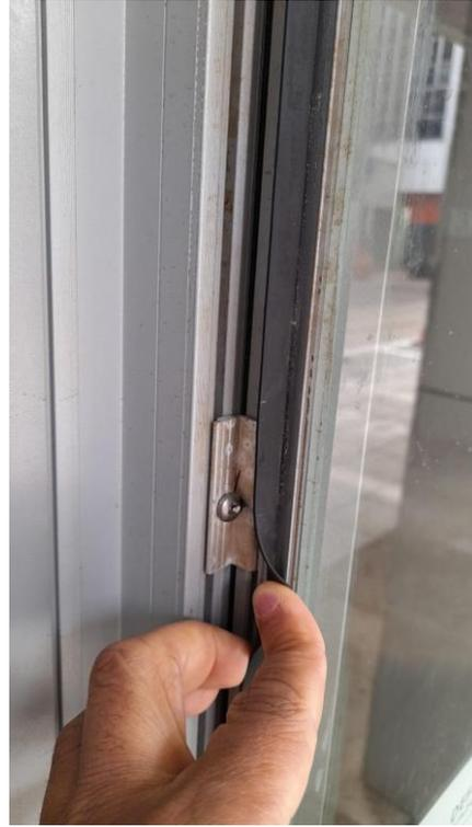
*Figura 4 - Fixação dos quadros*
