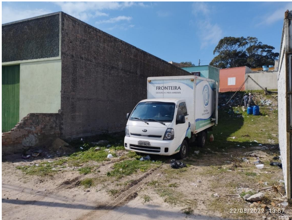
Figura 2 – Aspectos gerais dos serviços.
